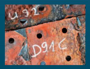
Zum Schutz der Umwelt wurden von der zuständigen Behörde erhebliche Auflagen erlassen, die während der Sanierung berücksichtigt werden mussten. Die gesamte Beschichtung war nach heutiger Definition schadstoffbelastet (Kupfer, Blei, PAKs). Sie wurde mit einem Nassstrahlverfahren (2.500 bar) entschichtet. Das entstehende Abwasser wurde in Becken aufgefangen, chemisch behandelt und nach Freigabe durch das Umweltamt eingeleitet. Die entstandenen Schlämme wurden auf einer Sondermülldeponie entsorgt.
