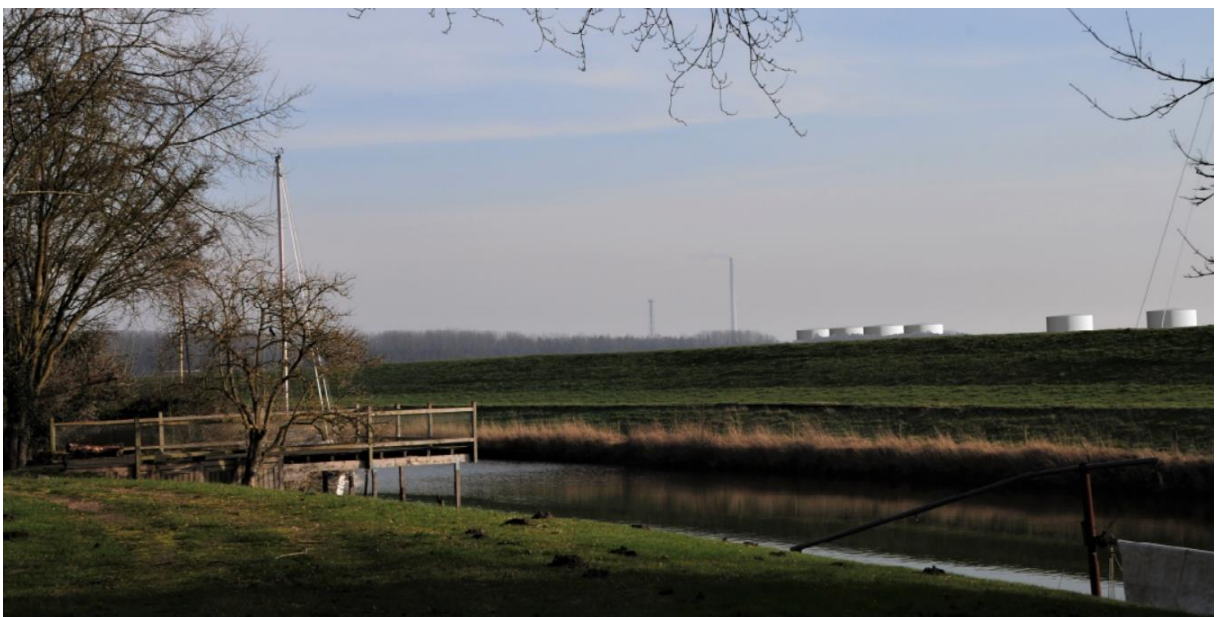
Abbildung 14: Fotopunkt 07 mit realistischer Darstellung der Anlagen, Blick in Richtung des Plangebietes und des Betriebsgeländes der Vynova
