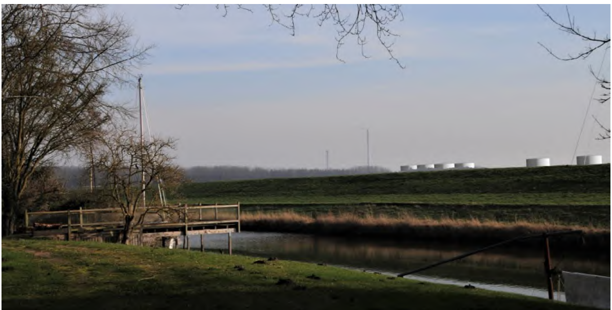
Abbildung 14: Fotopunkt 07 mit realistischer Darstellung der Anlagen, Blick in Richtung des Plangebietes und des Betriebsgeländes der Vynova
