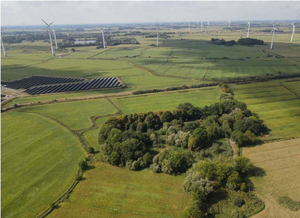
Abbildung 5: Blick auf die ehemalige Hofstelle Bauens (09.09.2022)
