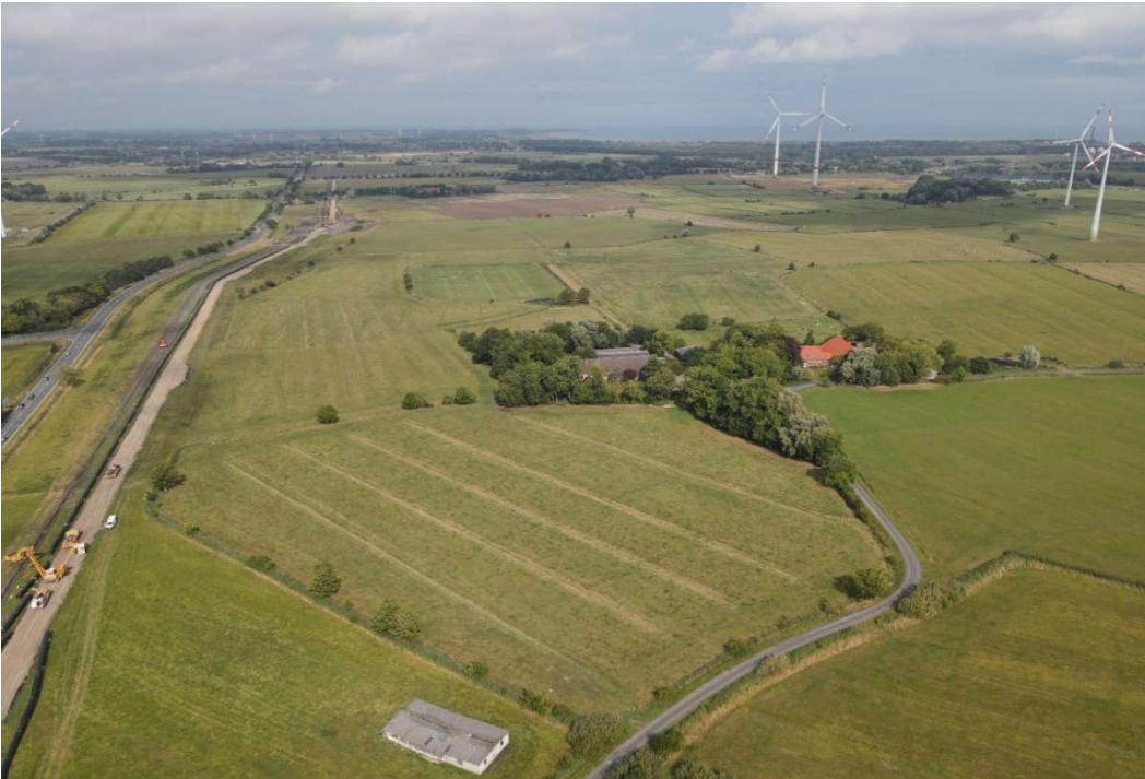
Abbildung 3: Blick auf Idschenhausen und die Hooksieler Landstraße (linker Bildrand). Parallel zur Landstraße ist die Baustelle für die LNG-Pipeline zu sehen (09.09.2022)
