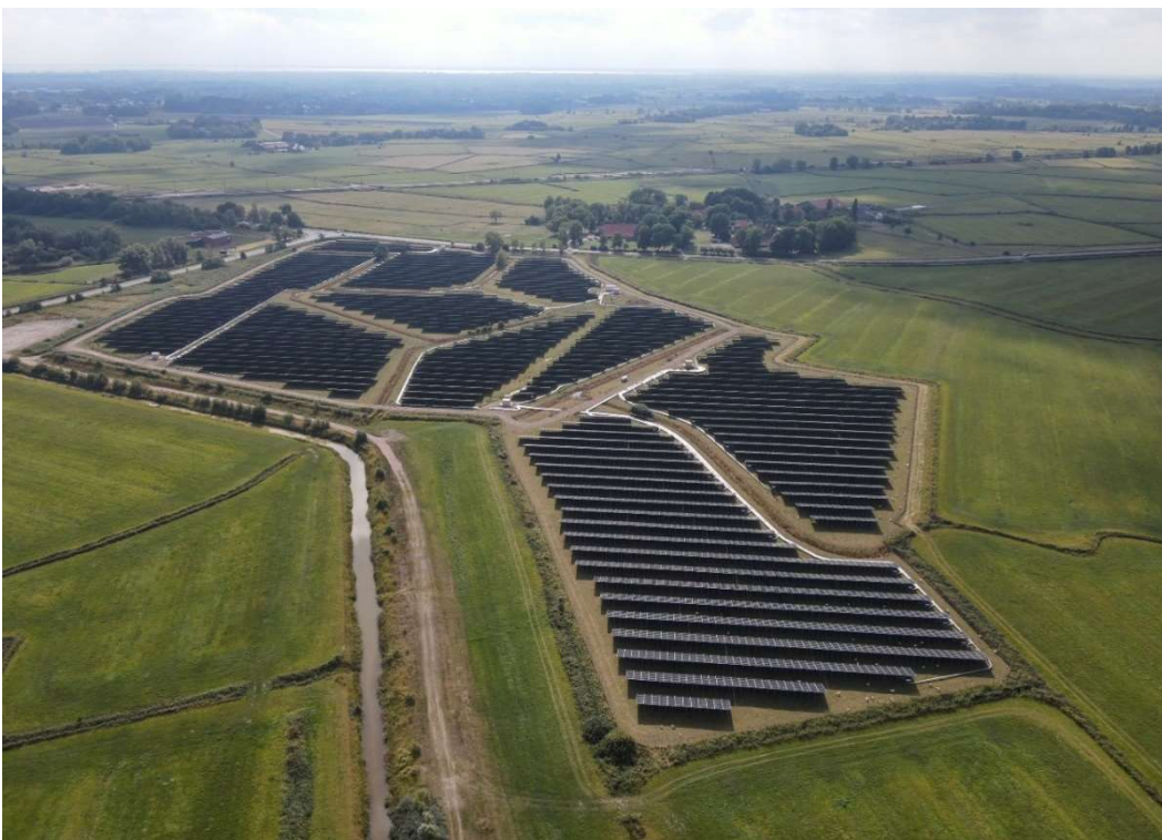
Abbildung 6: Blick auf den Solarpark nördlich von Uppers (09.09.2022)
